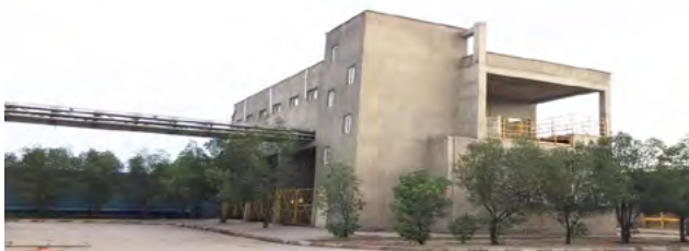
پروژه افزایش ظرفیت پمپخانه مرکزی
