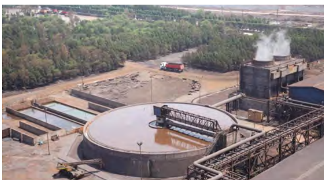
پروژه احداث سیستم آب مدار باز زمزم ۲
