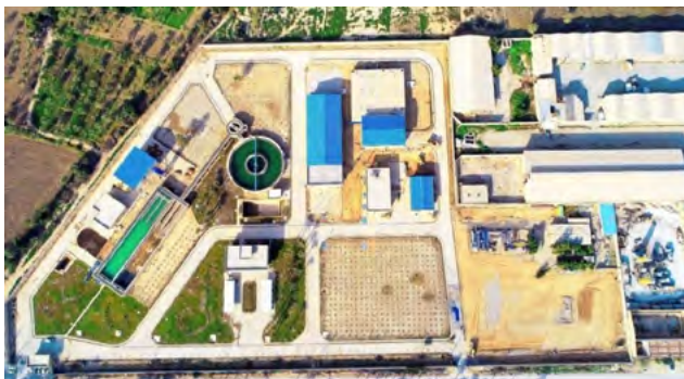
پروژه احداث تصفیه‌خانه جدید کوت عبدالله
