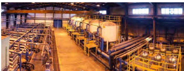
پروژه فاز دوم توسعه کارخانه RO
